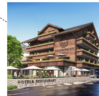
NEUERÖFFNUNG HOTEL FISCHERBLICK IN GRINDELWALD
